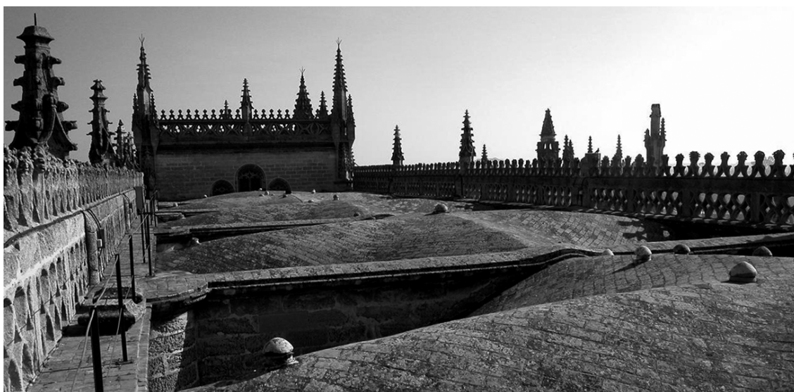
Fig.15. Diafragmas en las cubiertas de la nave principal (fotografía de R. Benítez)
