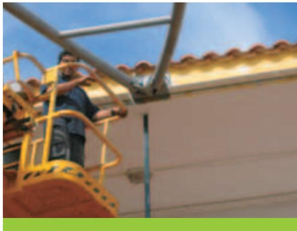
material textil, y que se conecta a los paramentos existentes mediante angulares de acero. La estructura se vincula al suelo mediante cuatro zapatas y al edificio existente mediante anclajes potenciados con resinas.
