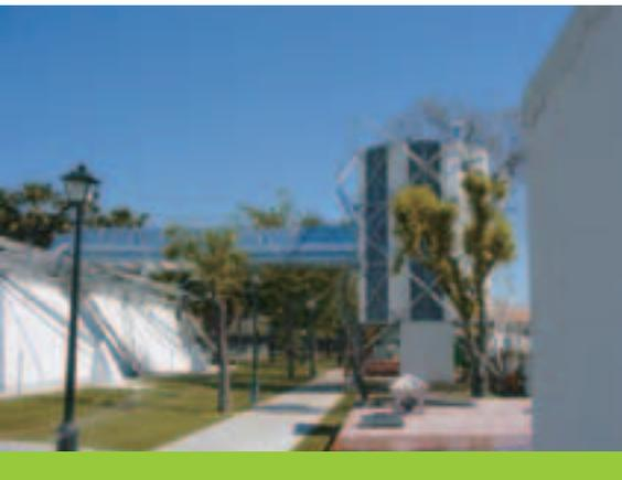
Como solución constructiva se propone una cubierta espacial, de forma cilíndrica y planta rectangular, formada por Perfiles Tubulares de acero de sección circular (CHS), que se apoya en otra estructura perimetral de nudos atornillados, de total desmontabilidad. La maquinaria específica para la climatización del recinto cubierto, se proyecta en un módulo diferenciado, con idéntica tipología estructural.
